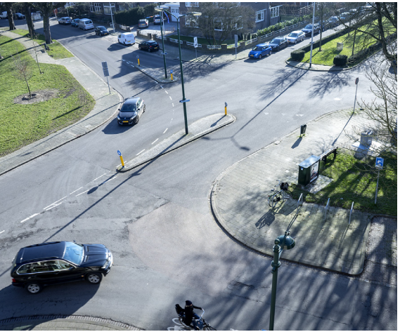
Aanleg van een rotonde?
