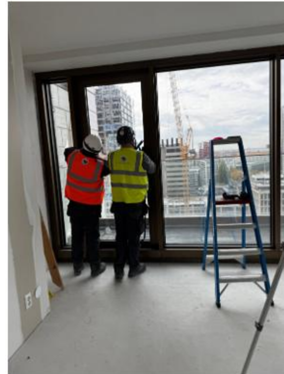
Na meerdere afstelling pogingen, alsmede vernieuwing van de kaderdichting goed resultaat gehaald.
